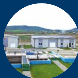
IZGRADNJA VODARNE ZA REGIJO VUSHTRII
