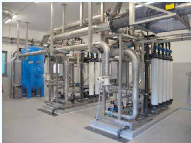
Vodarna Globel, ultrafiltracijski enoti
