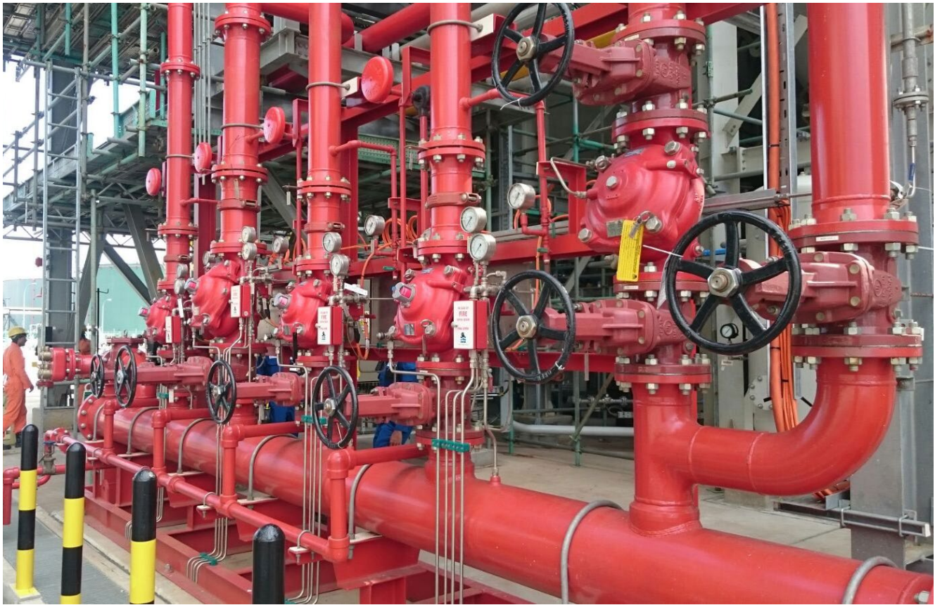
Slika 6: Tlačni reducirni ventili za sistem požarne zaščite
