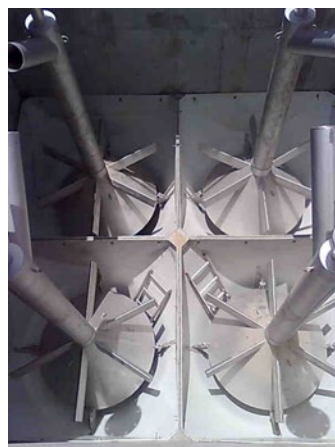
Slika 4: Distributorji namešчени v betonski bazen
