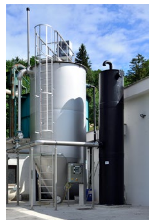
Slika 5: Kontinuirani peščen filter nerjavne izvedbe premera 2,5 m
